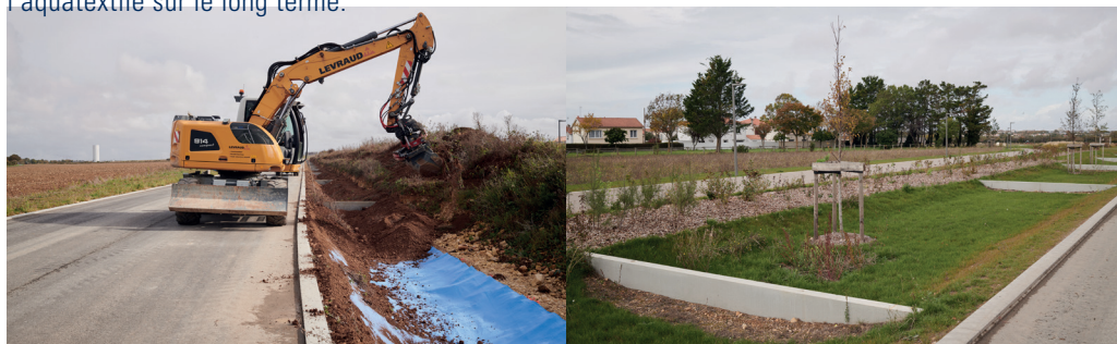
| Pose de l'aquatextile oléo-dépolluant actif TenCate GeoClean®
